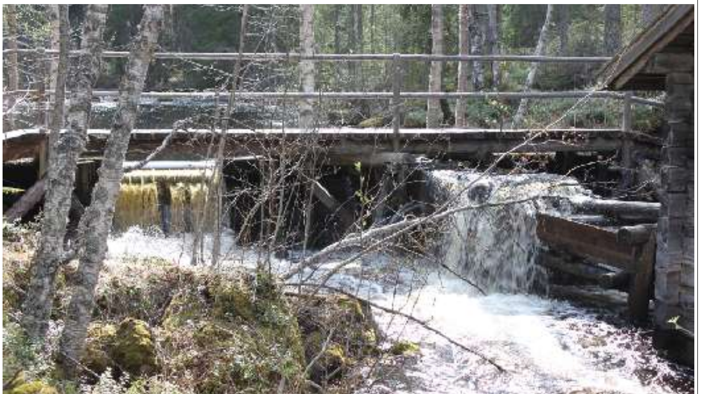
Vesi tulvi Lounatkosken myllypadon yli (HM)
